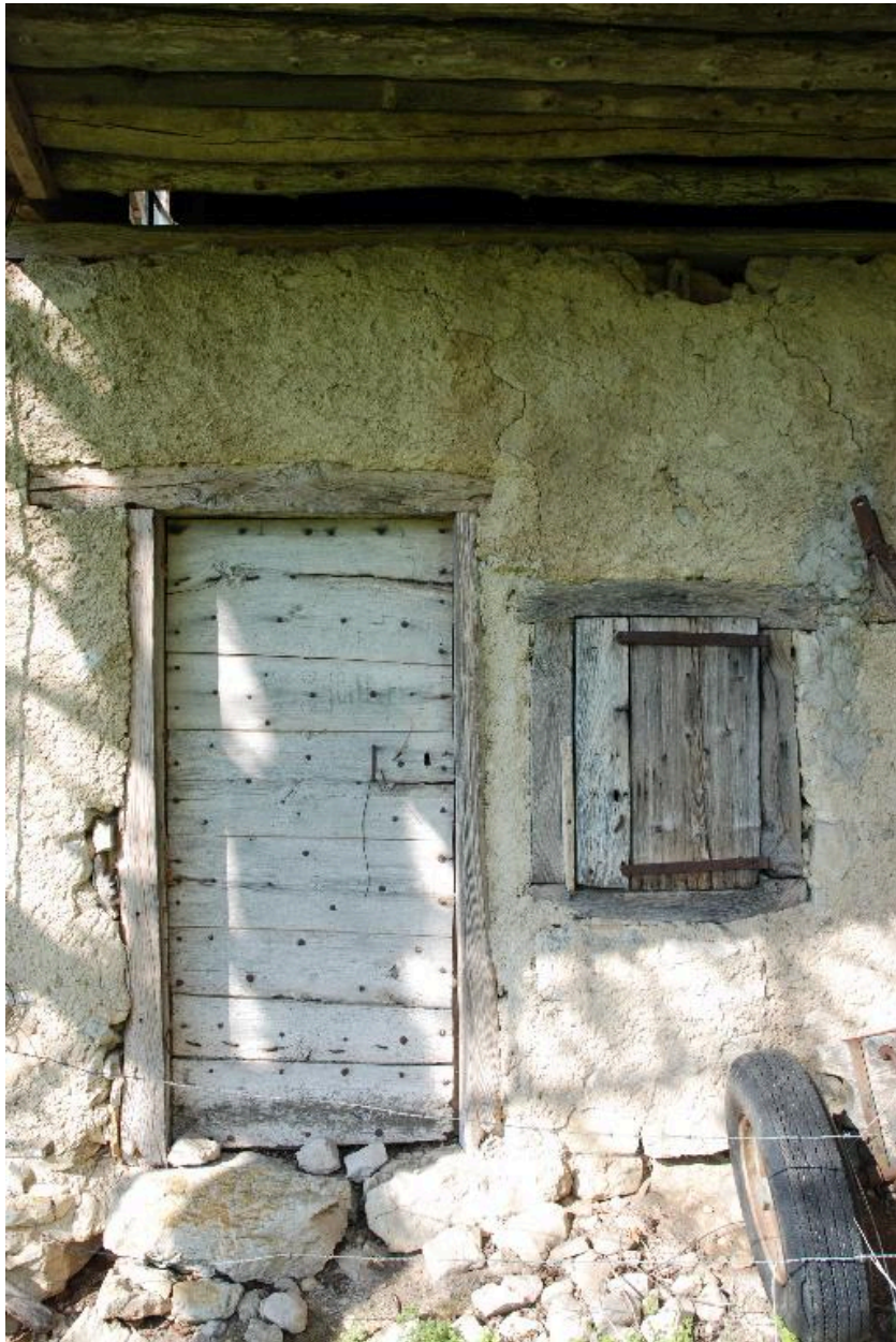
Détail des ouvertures de la façade sud : logis.
