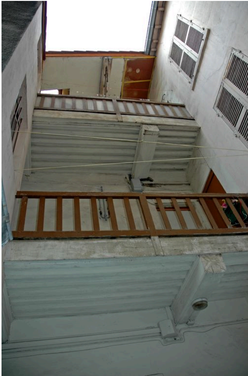
Vue d'ensemble des coursières
