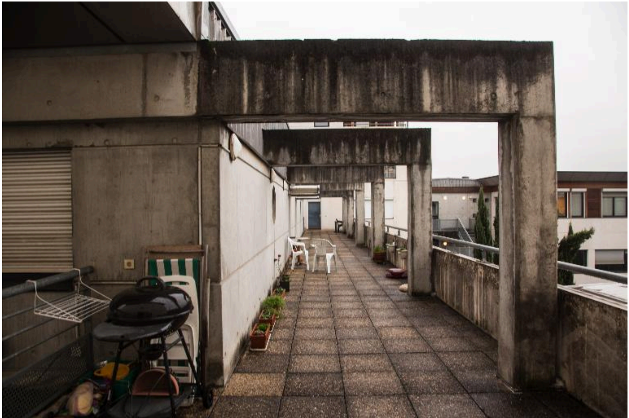
Bâtiment D. Détail
