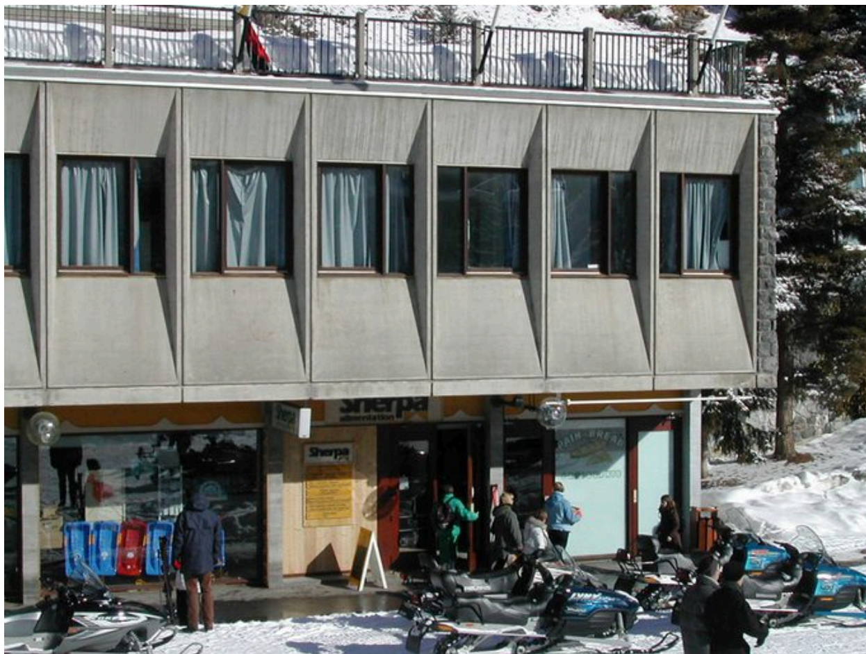
Extrémité orientale du bâtiment G
