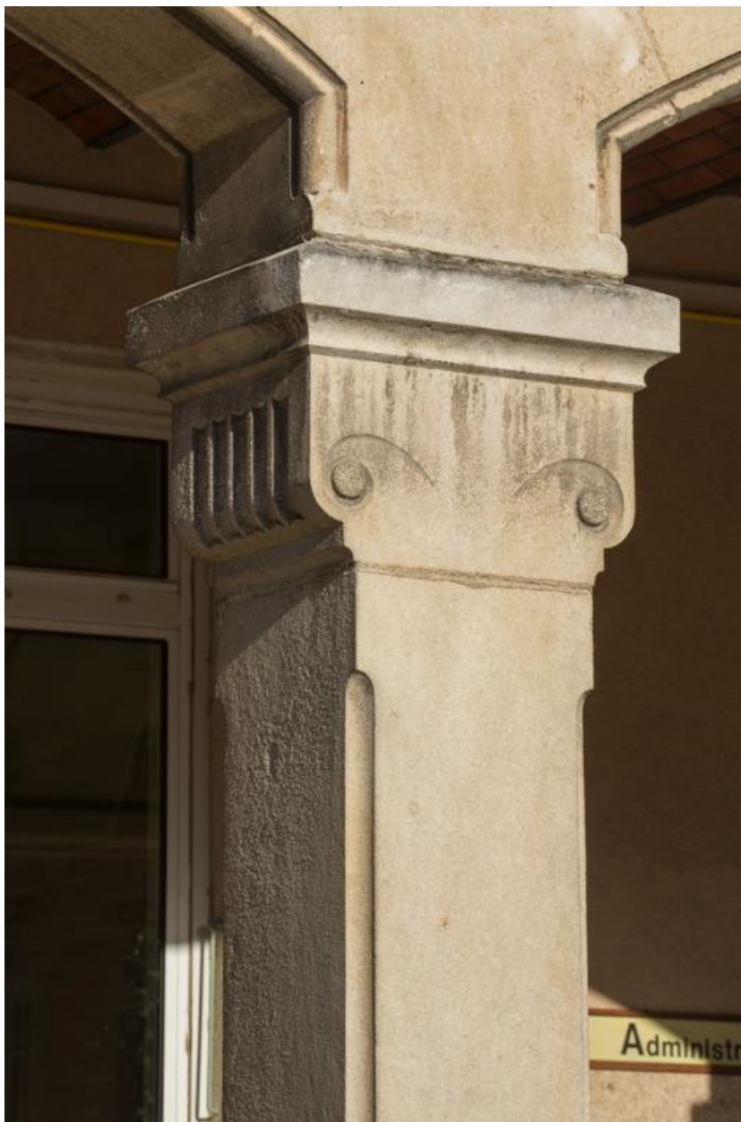
Portique : détail d'un pilier
