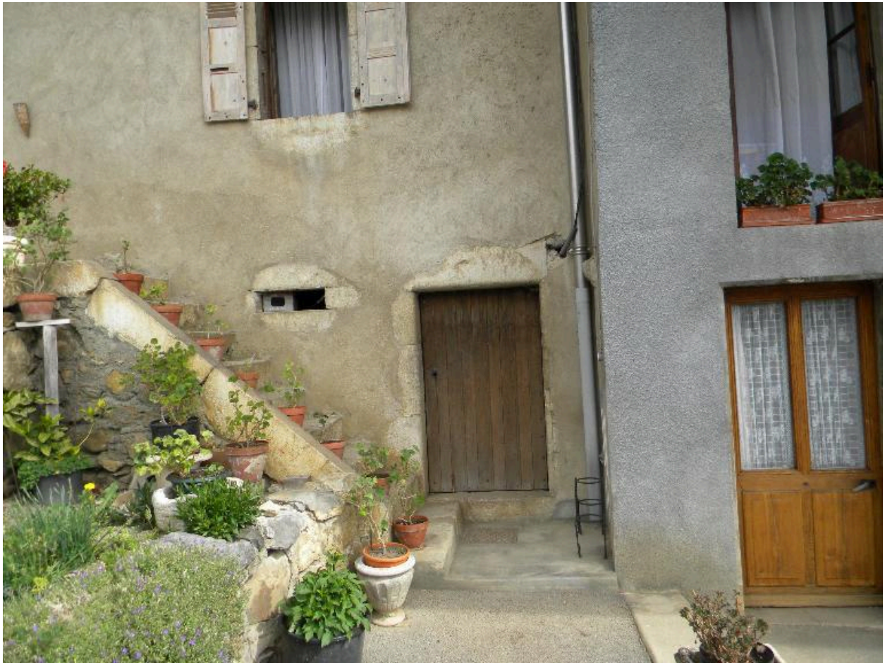
Vue de l'entrée de cave en façade.
