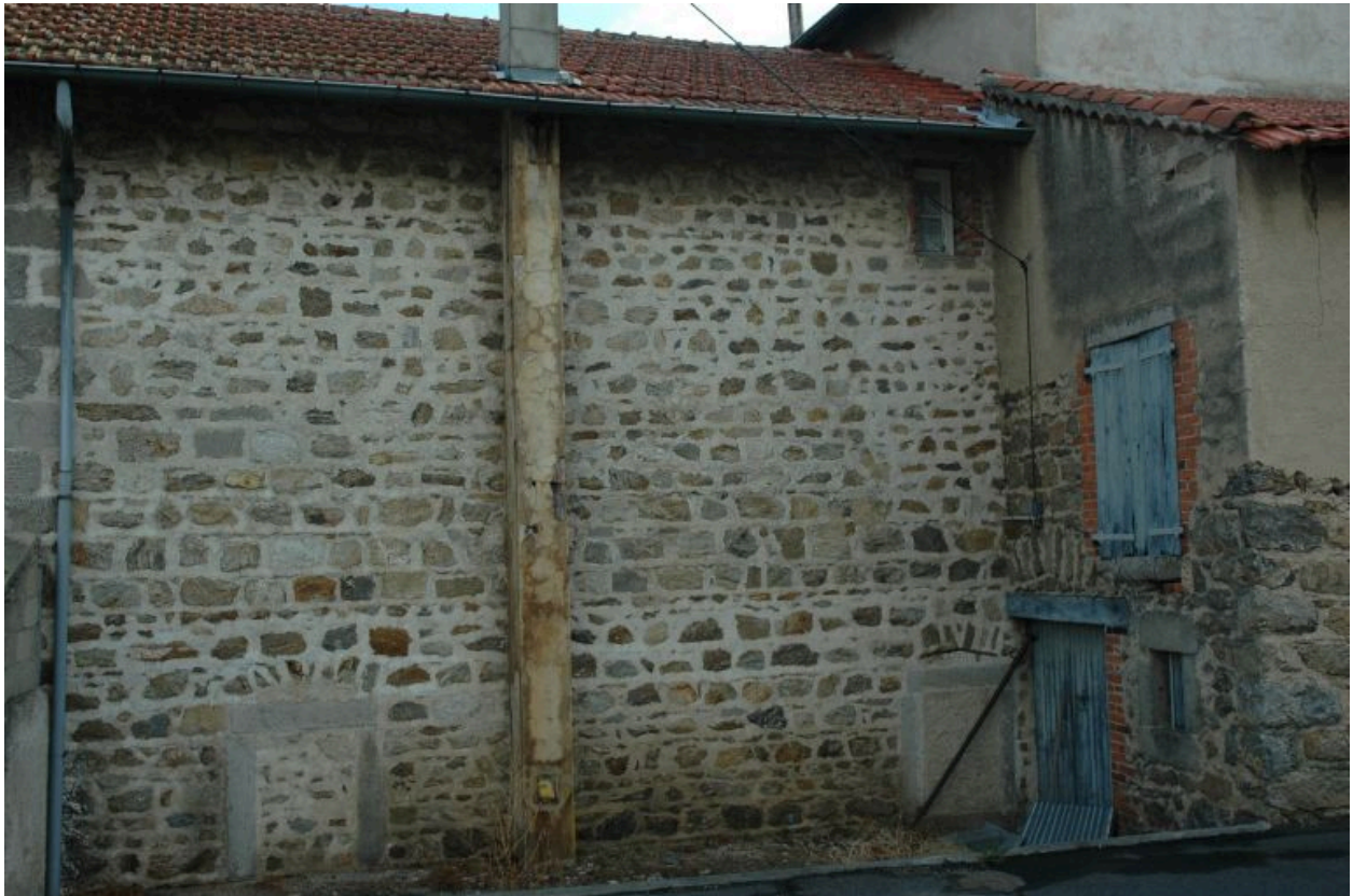
Rigaud, ferme, 1986 AB 323. Vue d'ensemble arrière du logis.
