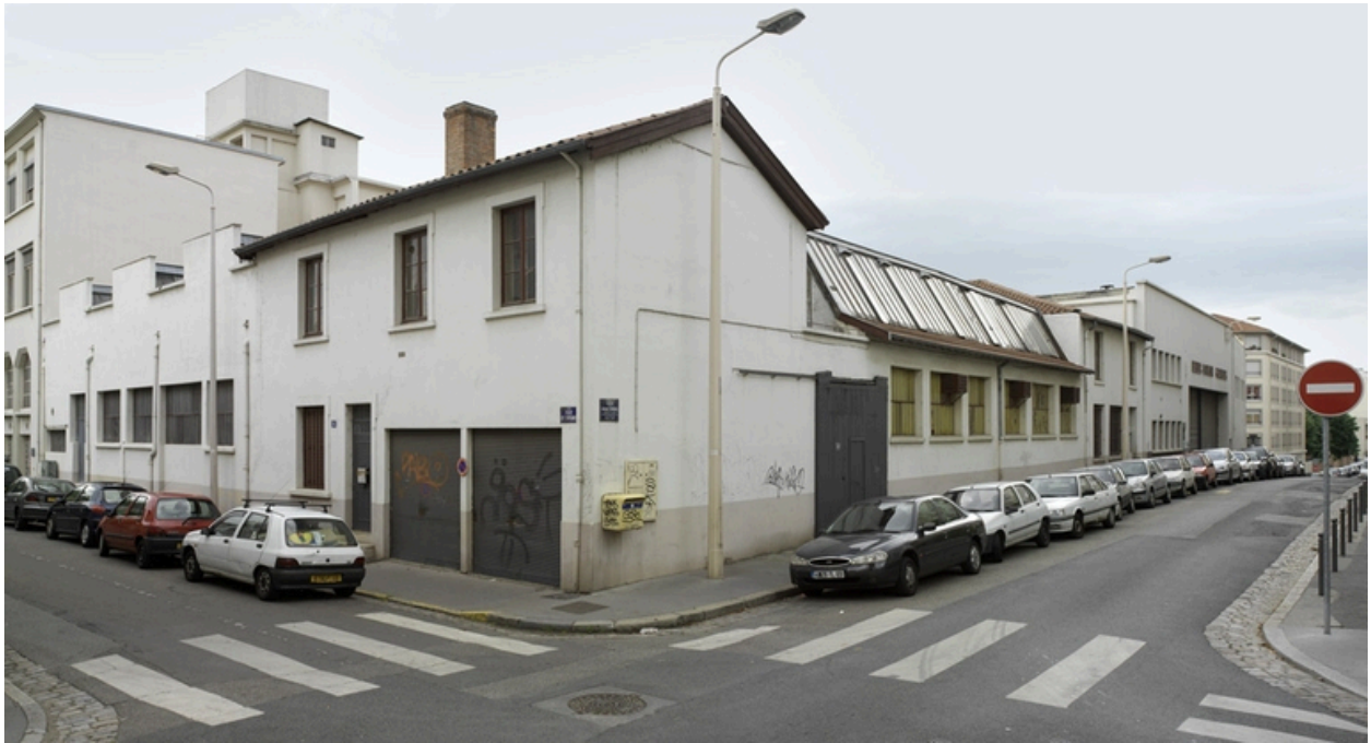
Vue d'ensemble nord-est du site
