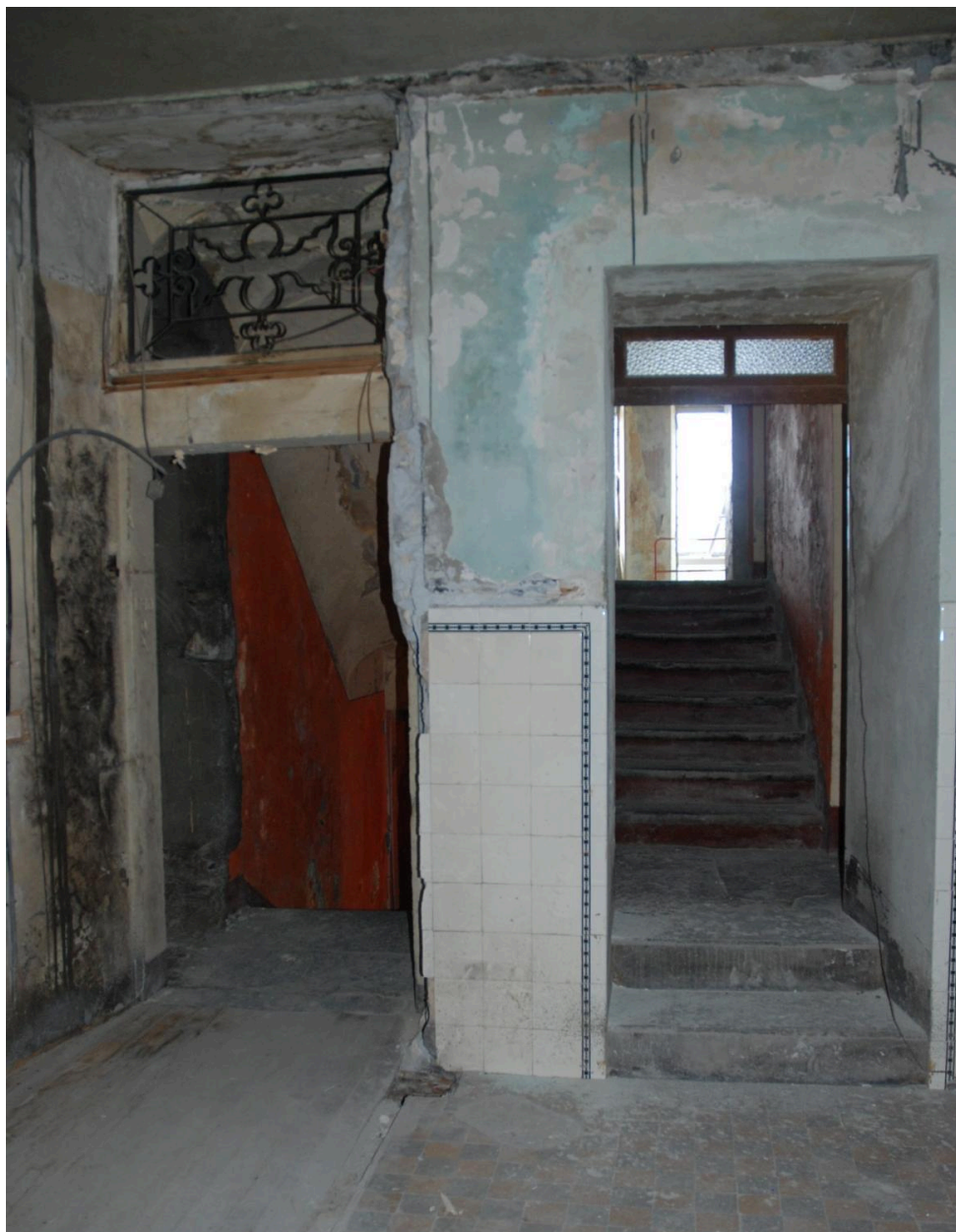
Vue intérieure du 1er étage : palier de l'escalier.
