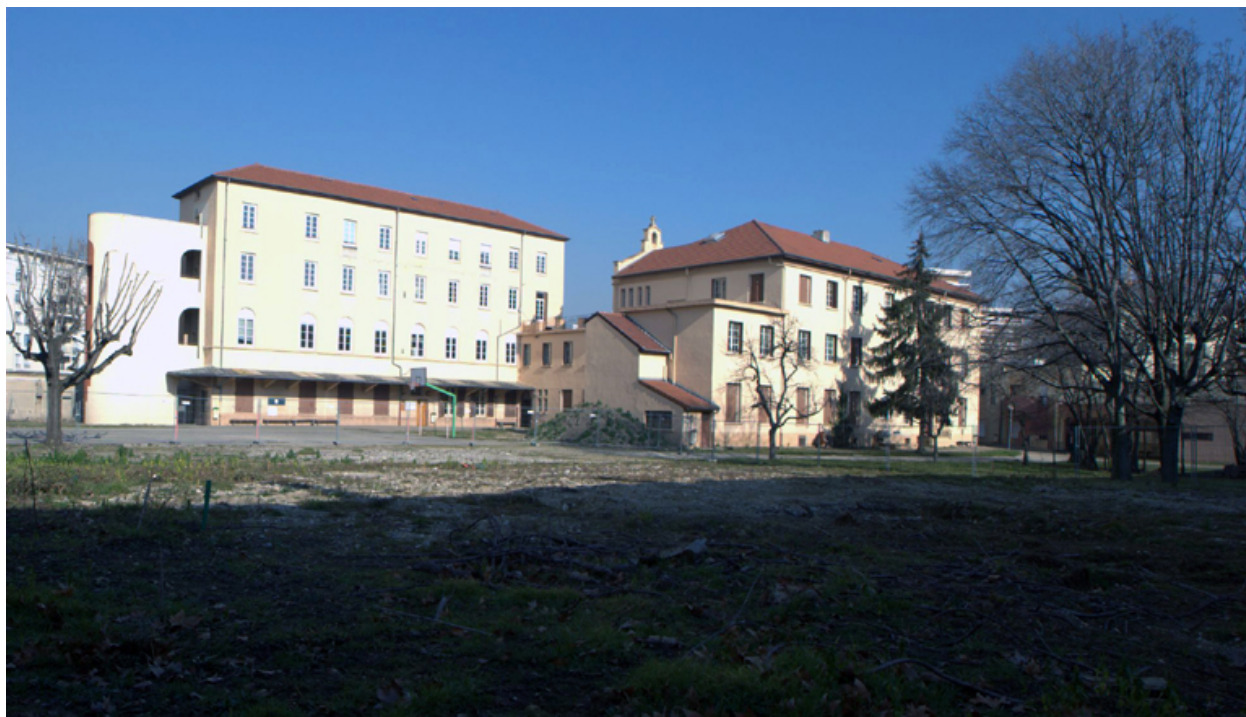
Vue d'ensemble (élévations postérieures) depuis le sud-ouest
