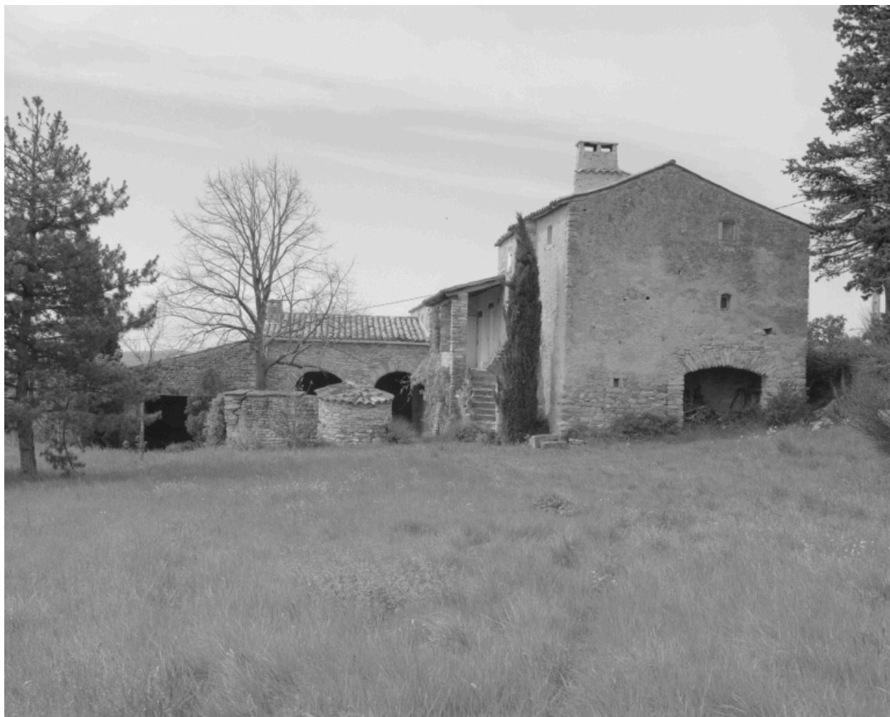
Chèvre, chemin de Taulignan au Poët-Laval. Vue générale de la ferme.
