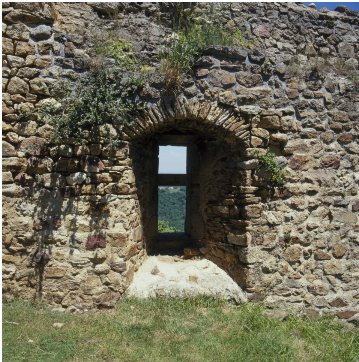
Courtine nord-est de la première enceinte entre la tour ronde (tour n°10 du plan) et l'ouvrage d'entrée, de l'intérieur : détail d'une fenêtre à traverse, du sud-ouest.
