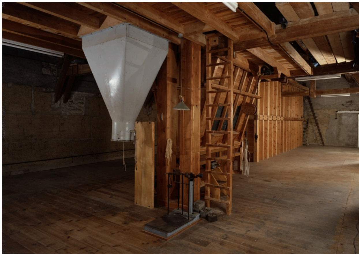
Premier étage, nord, vue d'ensemble : entonnoir d'ensachage, trémies et entrepôt des sons.
