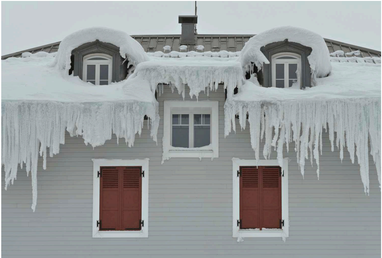
Façade arrière, détail du corps central, sous la neige.
