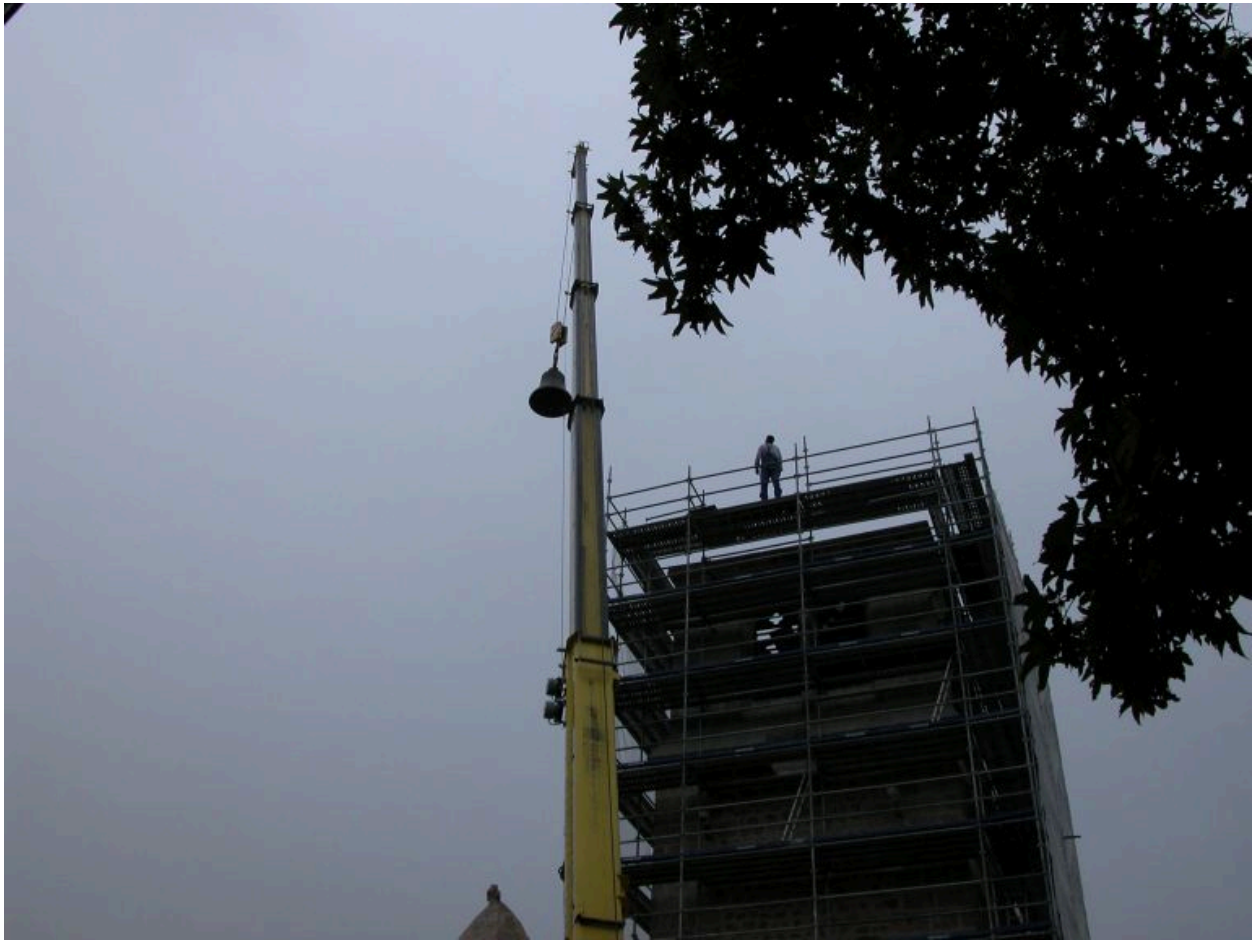
Cloche (n°2) élevée du sol et hissée jusau'au sommet du clocher.
