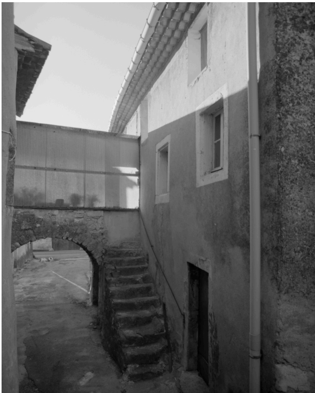
Le village. L'élévation principale et le soustet de la ferme (A1 156).
