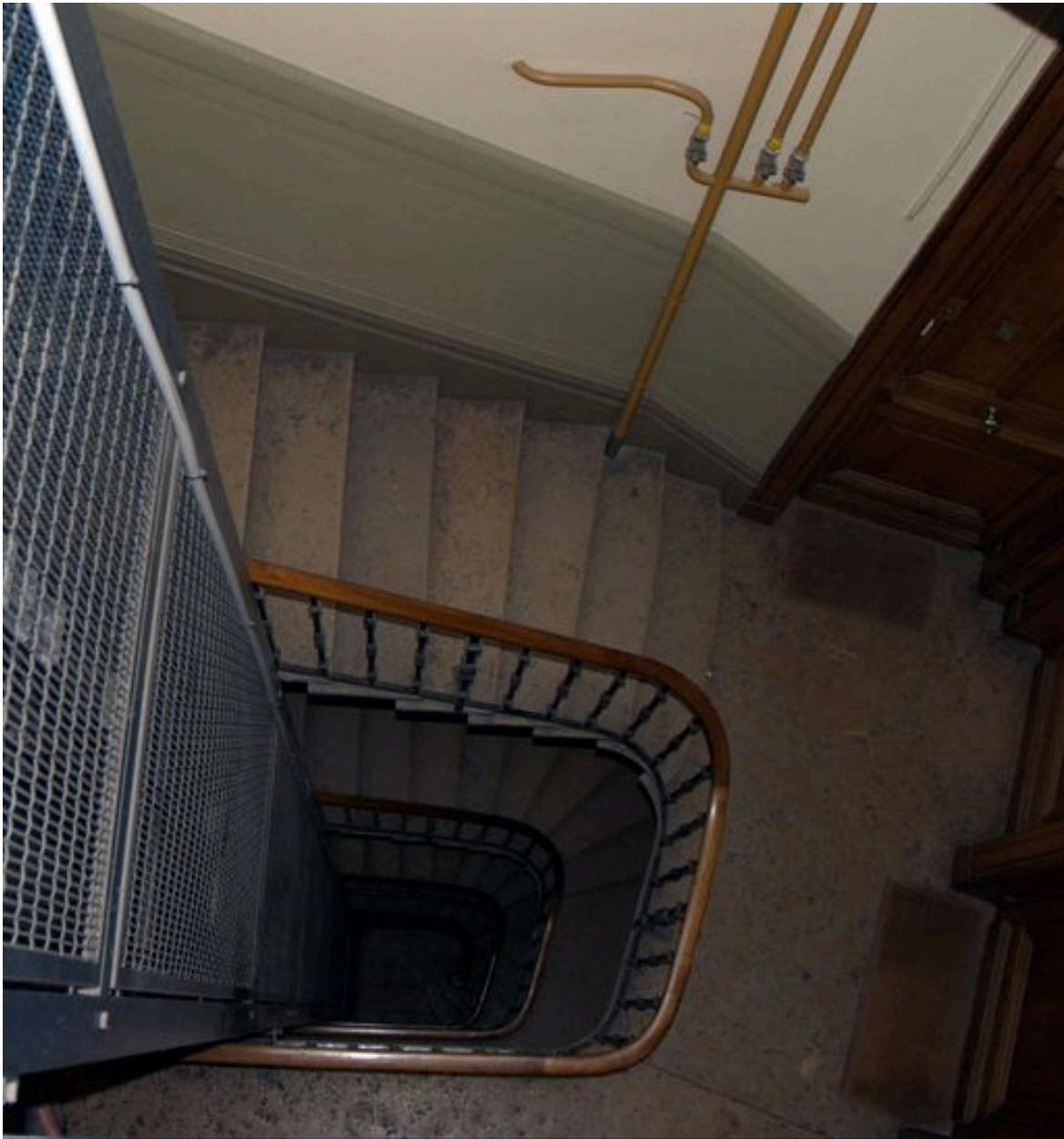
Vue de l'escalier depuis le haut
