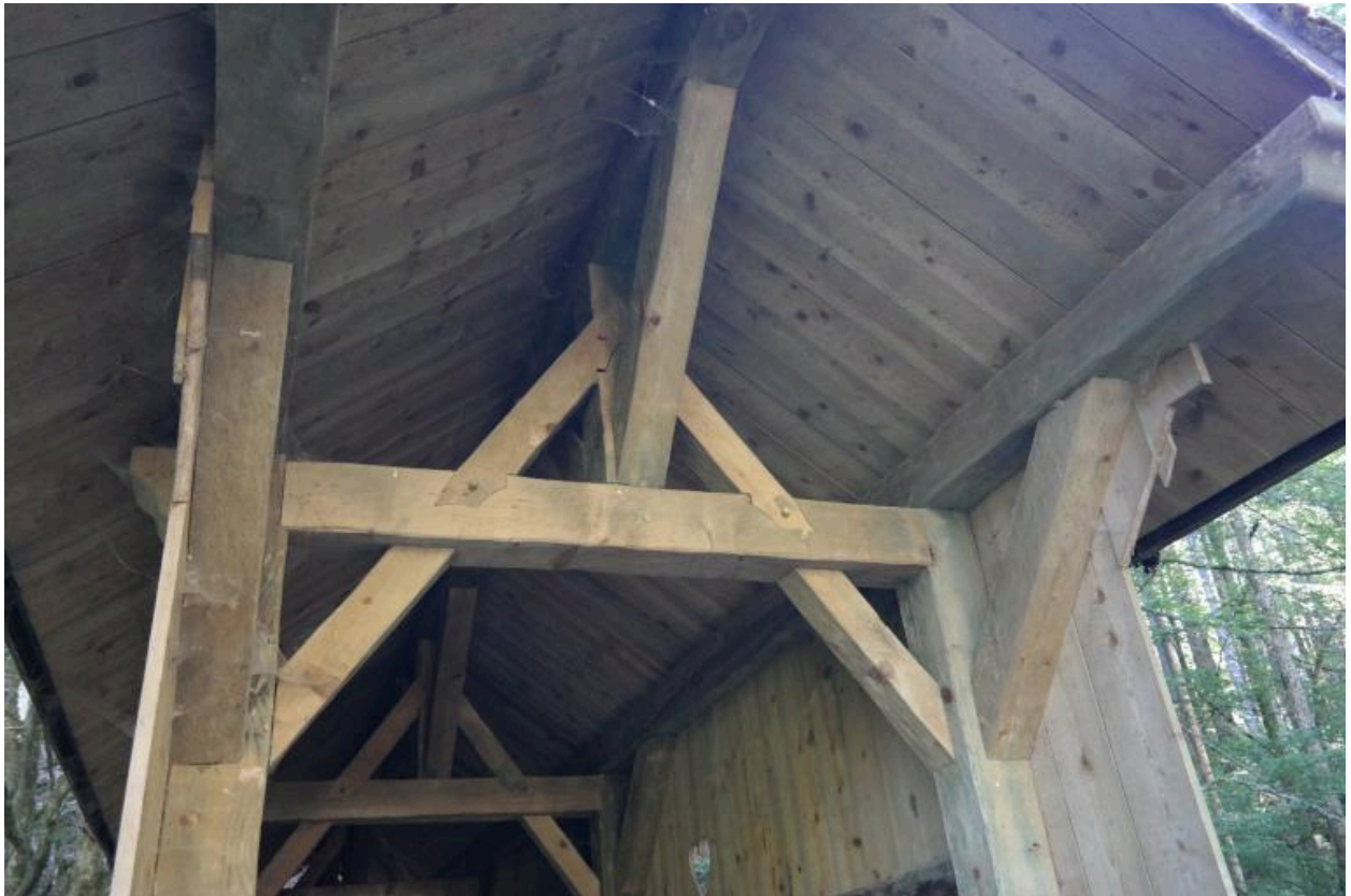
Pont couvert de Bellevaux, détail de la charpente
