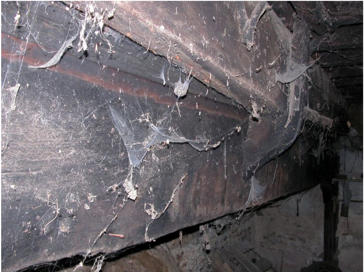
Détail du linteau de la cheminée.
