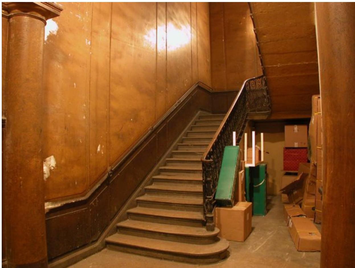
Escalier, palier du rez-de-chaussée
