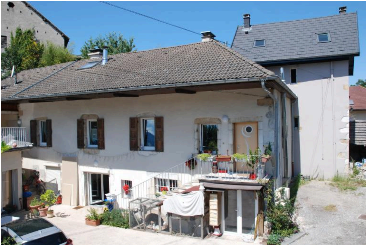
Ancien moulin de Grand Creux (Sur les Plants, 2017 C1 772, 773), non repéré.
