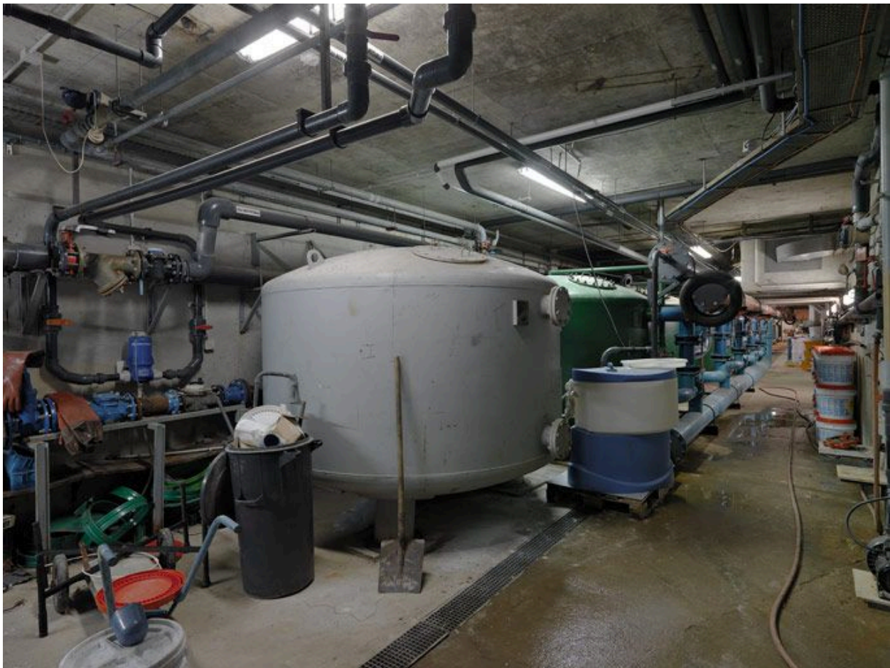
Vue de la chaufferie, dans le soubassement (état en juin 2012).
