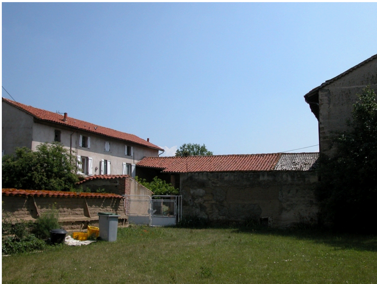
Vue générale, depuis le sud-ouest.
