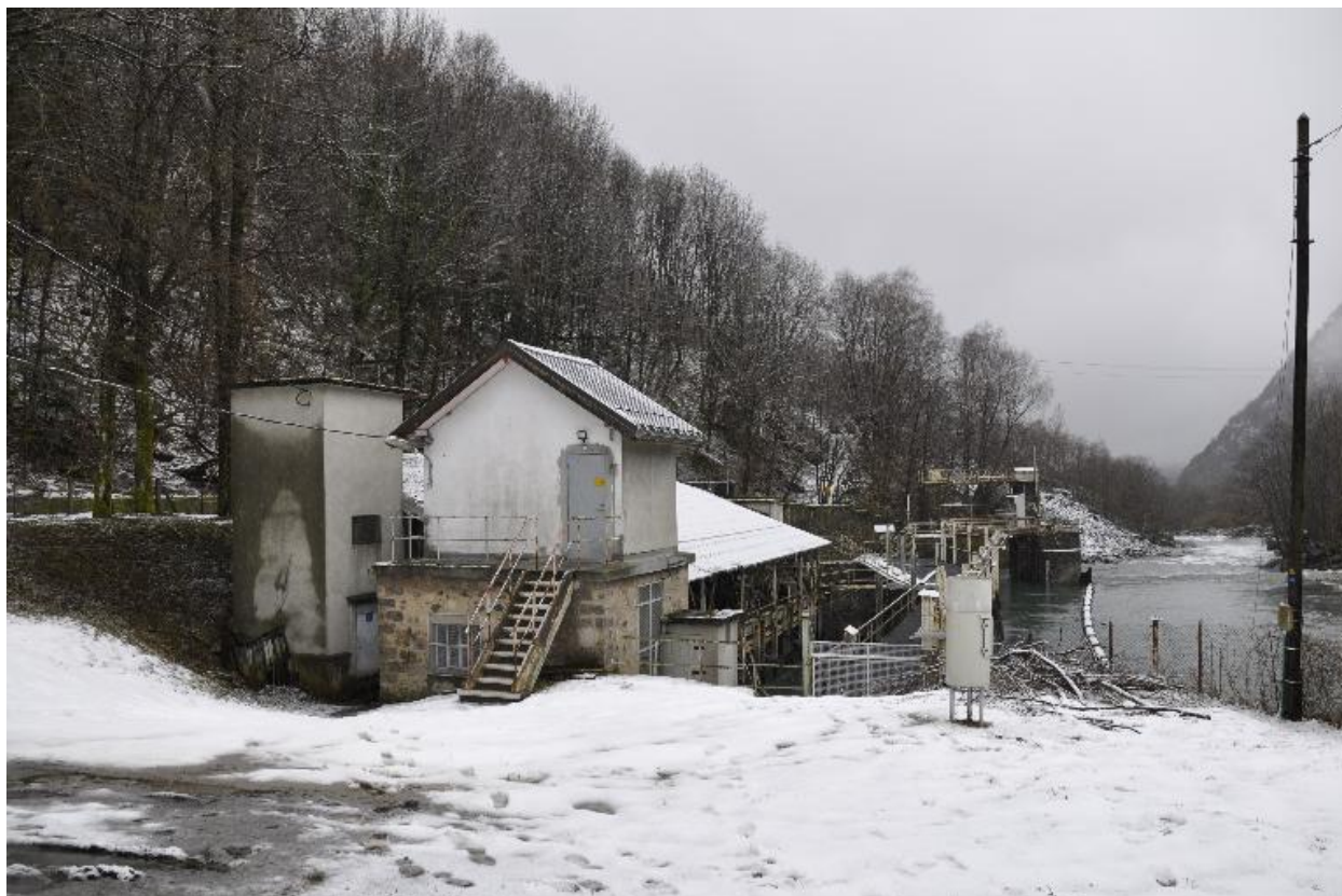
Local de commande du barrage de Livet
