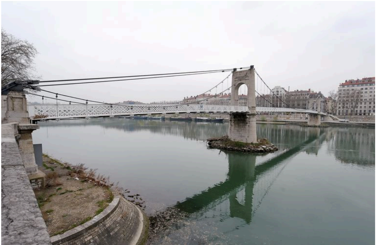
Vue générale, côté aval (depuis la rive droite)
