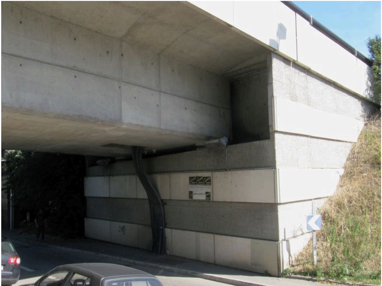
Culée de la rive droite, face amont
