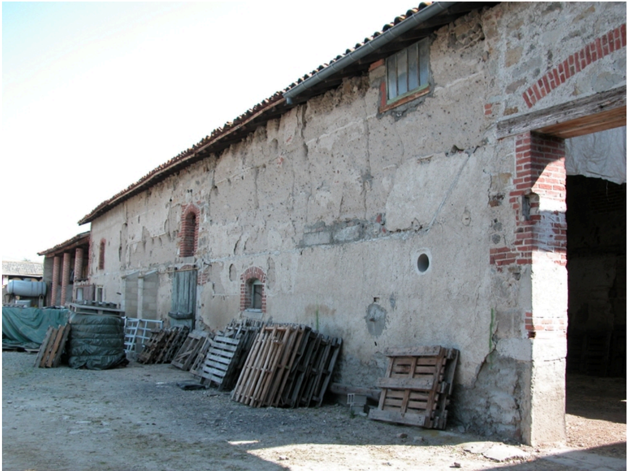
Vue de la grange-étable, depuis le sud-ouest.
