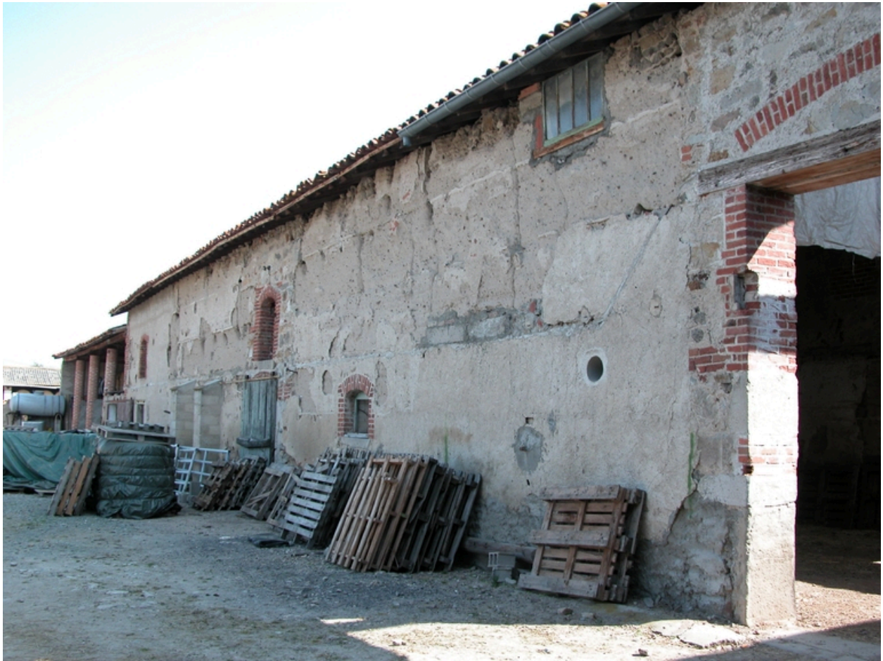
Vue de la grange-étable, depuis le sud-ouest.
