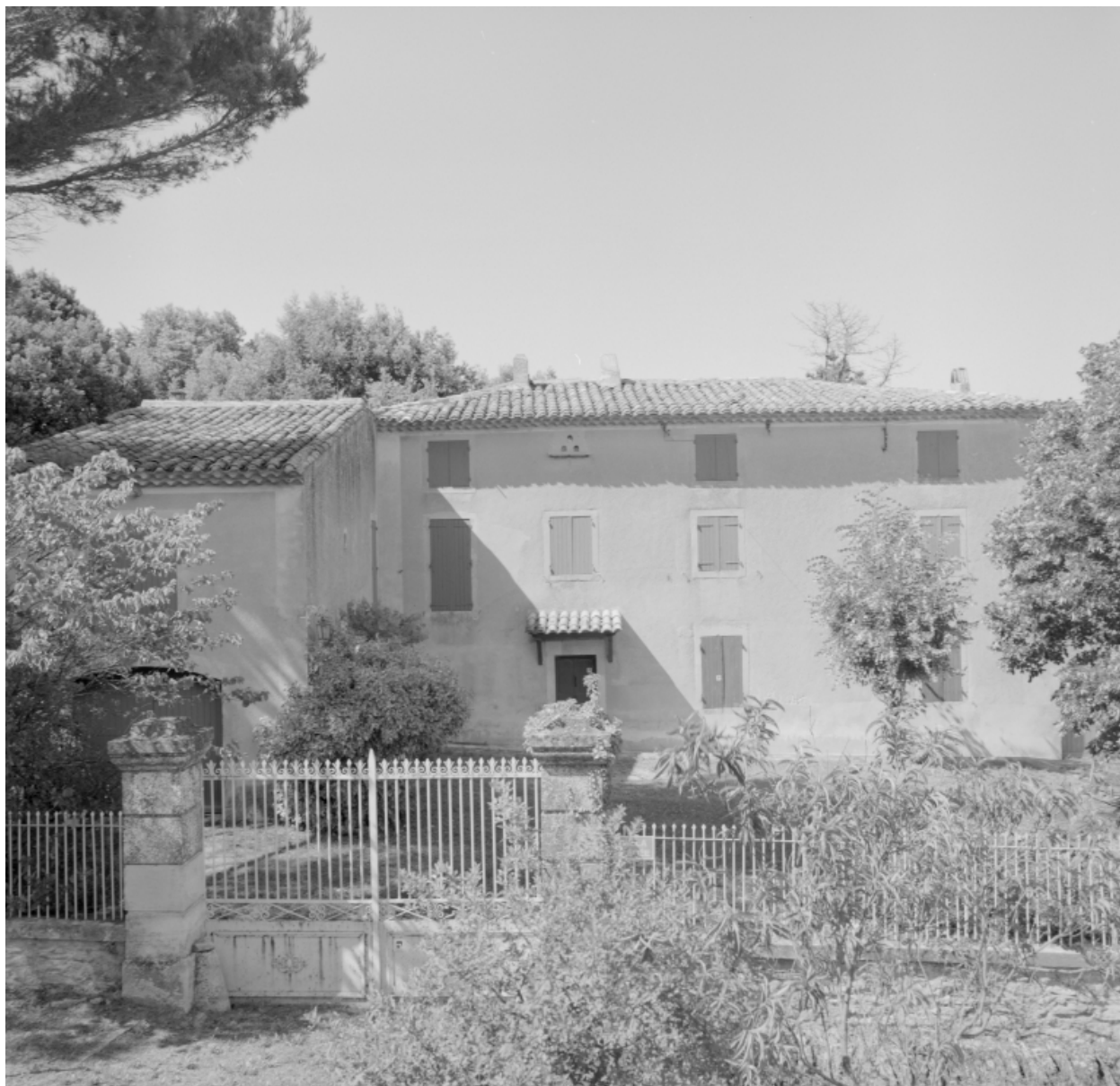
Les Launes. Elévation principale de la ferme (A1 450).
