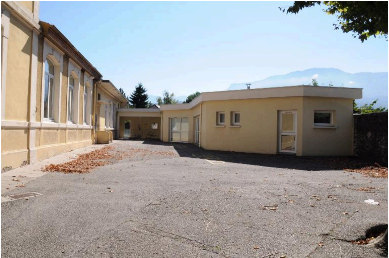
Façade latérale droite de l'école primaire et cantine
