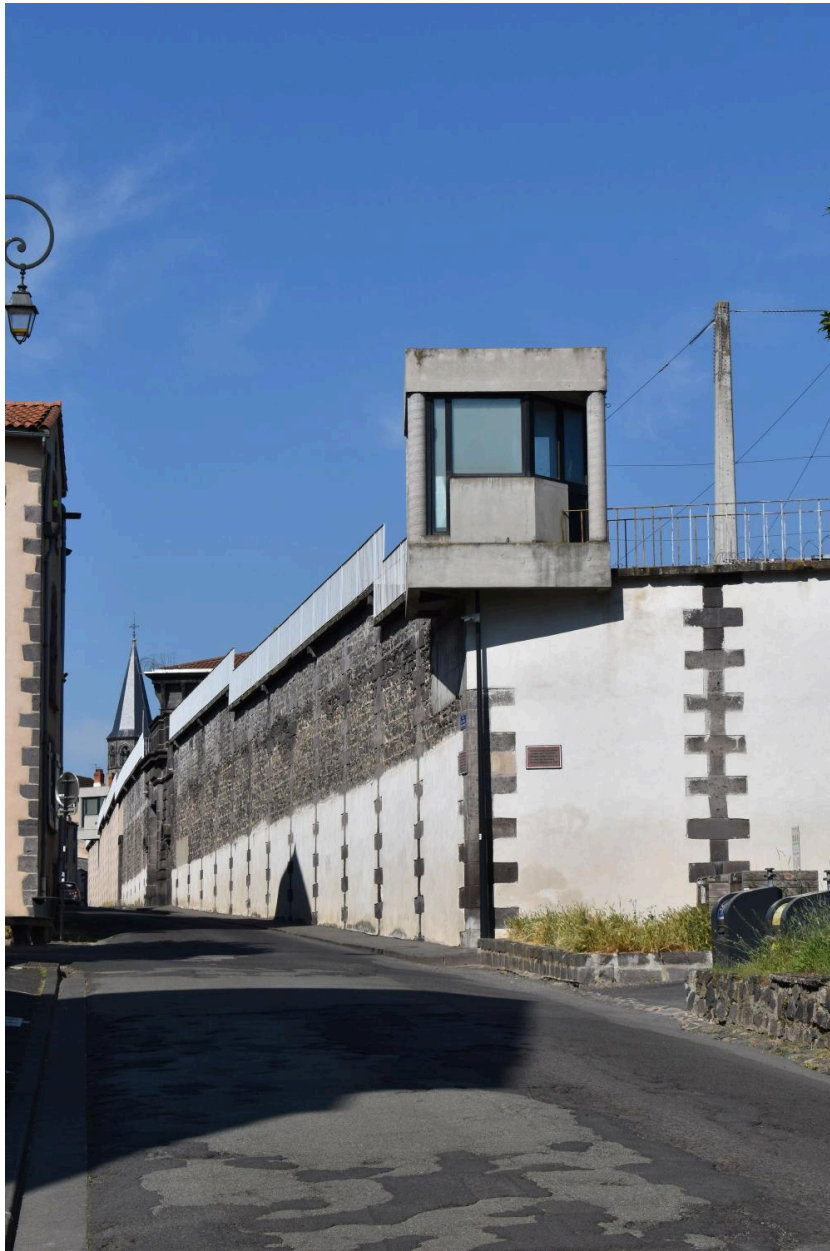
Mur d'enceinte de la prison avec mirador d'angle, depuis l'est de la rue de l'Hôtel-des-monnaies.
