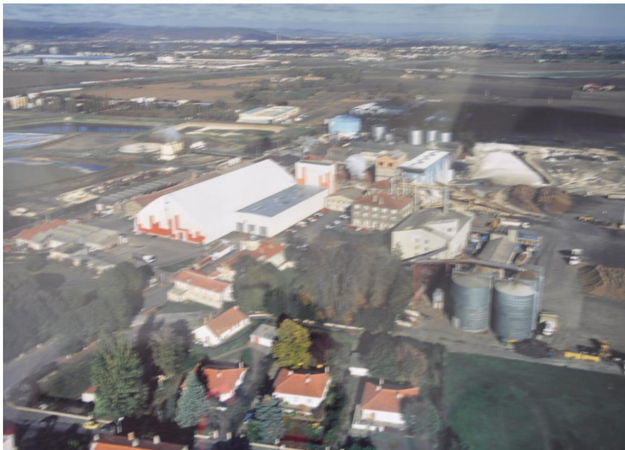
Vue aérienne de l'usine , image d'archive de l'usine.
