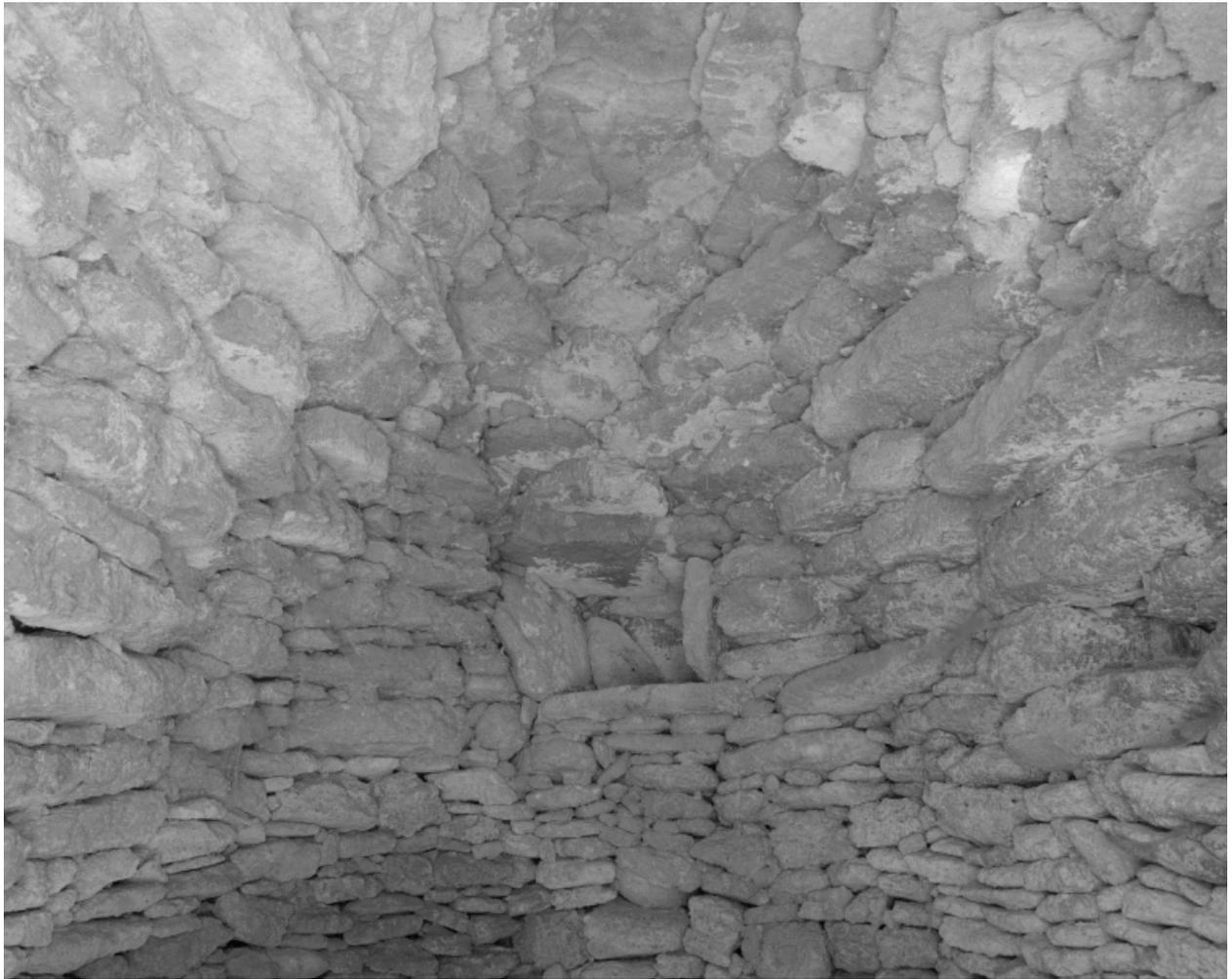
Taulignan, Esclouseau. Couvrement intérieur de la borie : principe de coupole en encorbellement.
