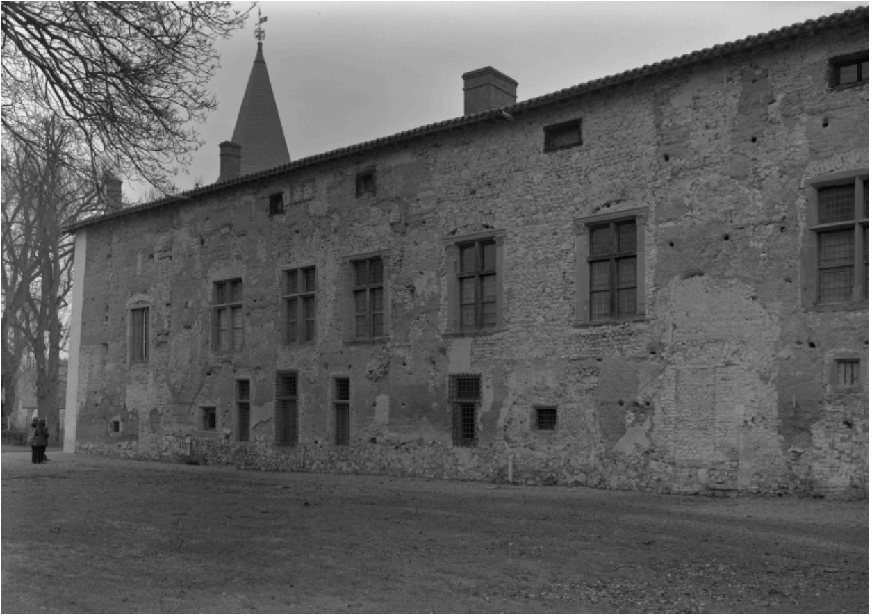
Vue générale de la façade sur jardin du corps de galerie, après décroûtage.
