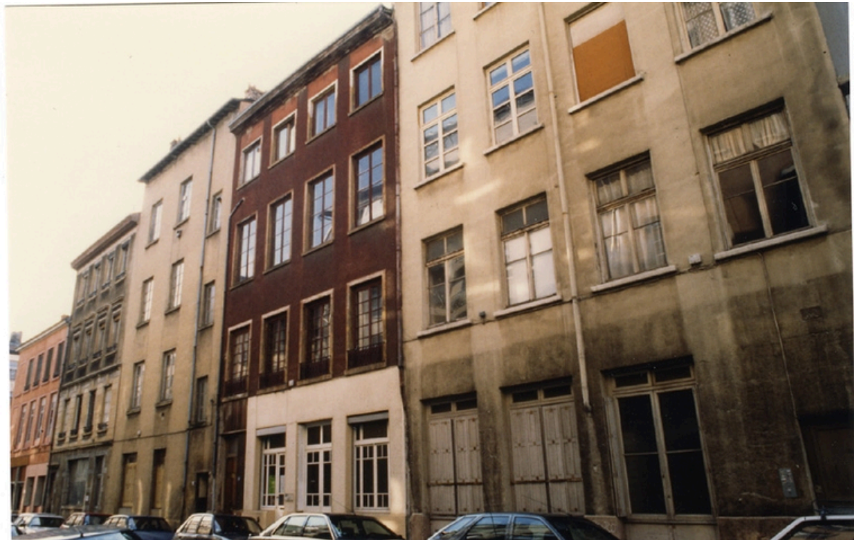
Vue générale de l'immeuble atelier
