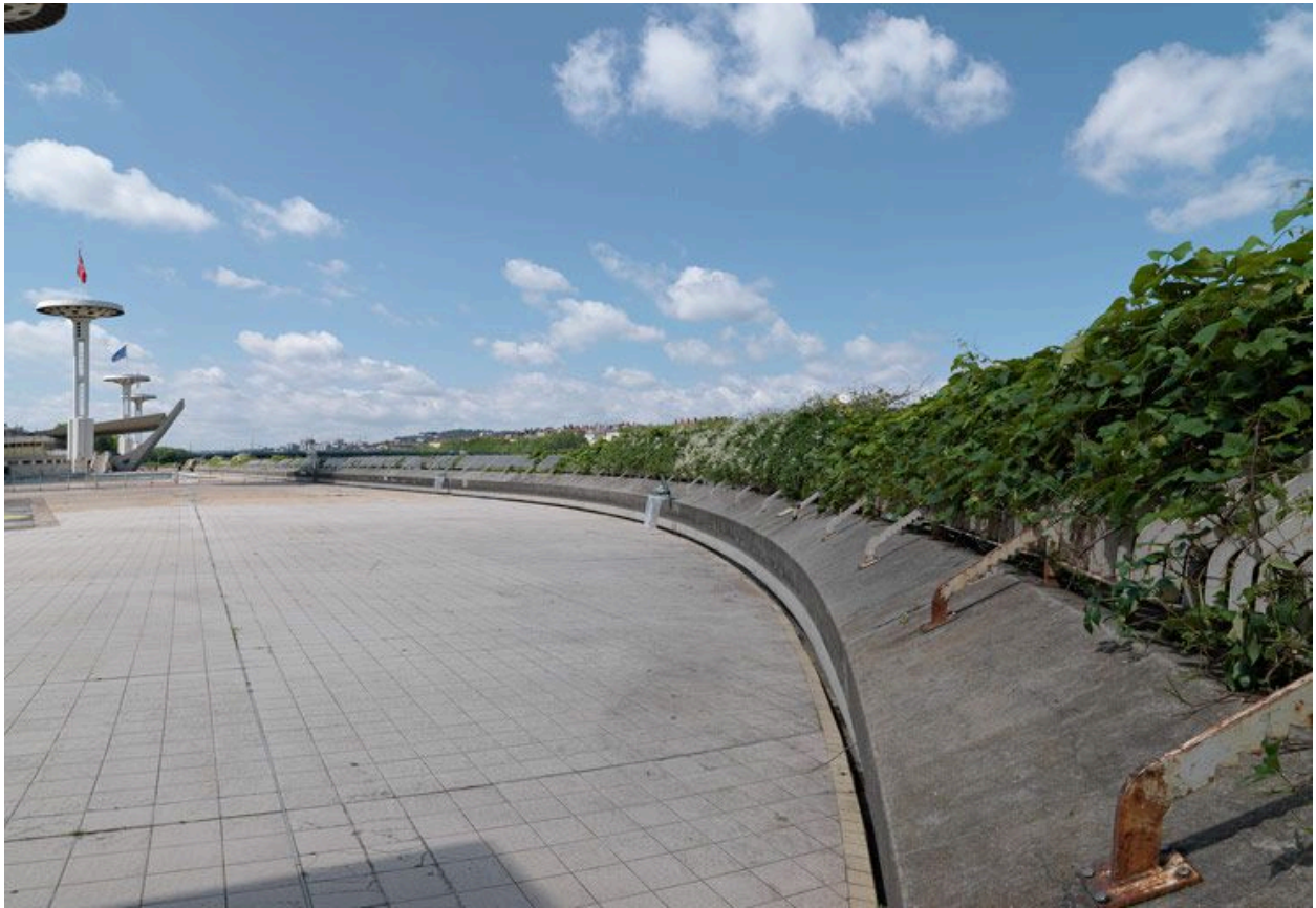
Partie nord de la piscine : le mur de clôture avec l'estacade (état juin 2012).
