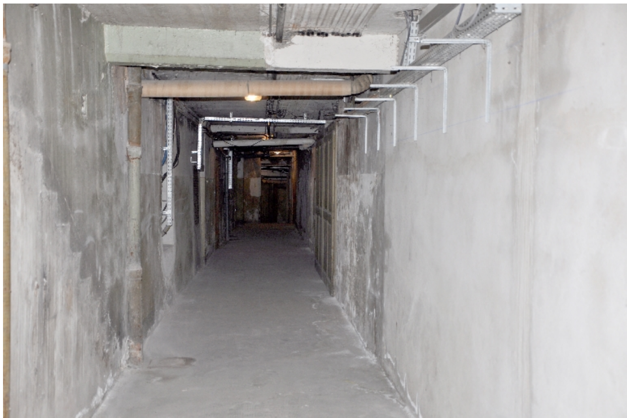
Sous-sol de l'aile N-W : couloir
