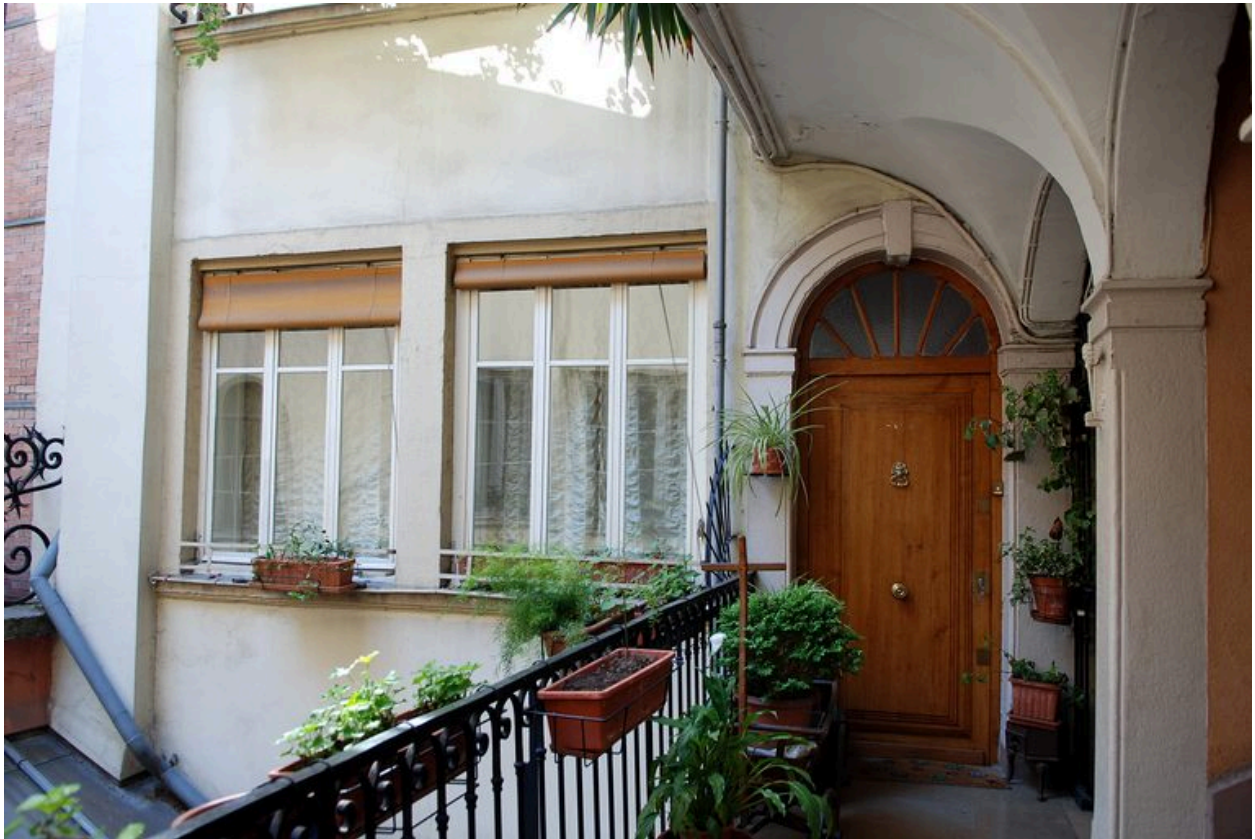
Corps de bâtiment ouvrant sur la rue de Brest : vue partielle de l'élévation sur cour depuis le palier de l'escalier
