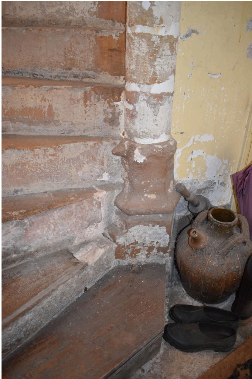
Vue de détail du noyau de l'escalier en vis, à base moulurée.
