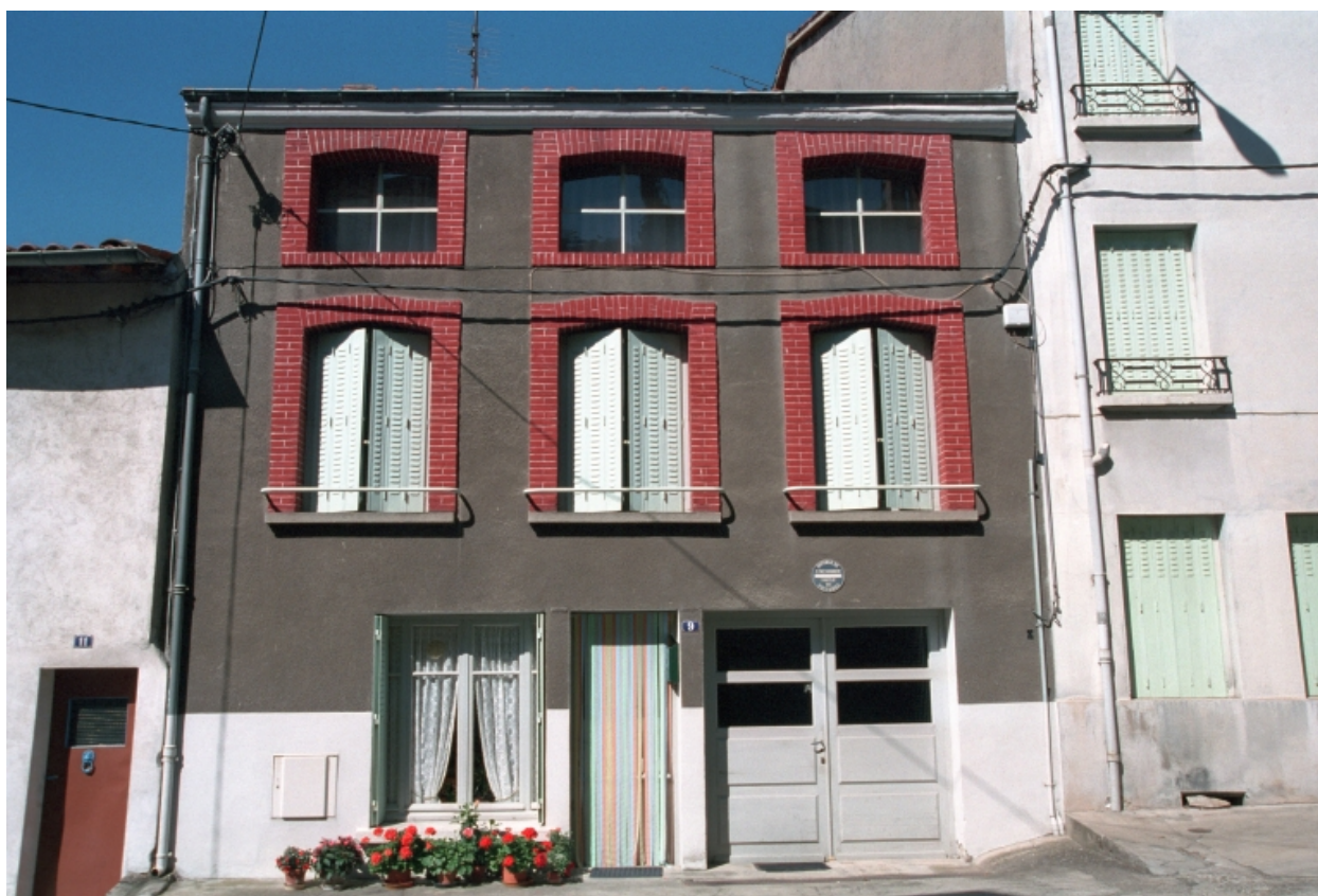
Boën, îlot 13, Gustave Labrosse (rue) 8. Vue générale de la façade sur rue.
