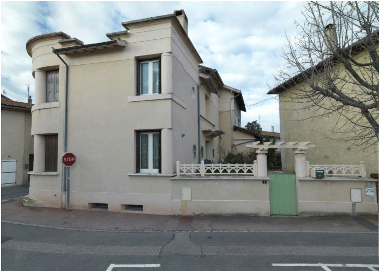
1986 AE 446. 7 rue Georges Guynemer. Maison des années 1950 ayant appartenu à la famille Nourrisson, élévation de la façade sur le place du Château.
