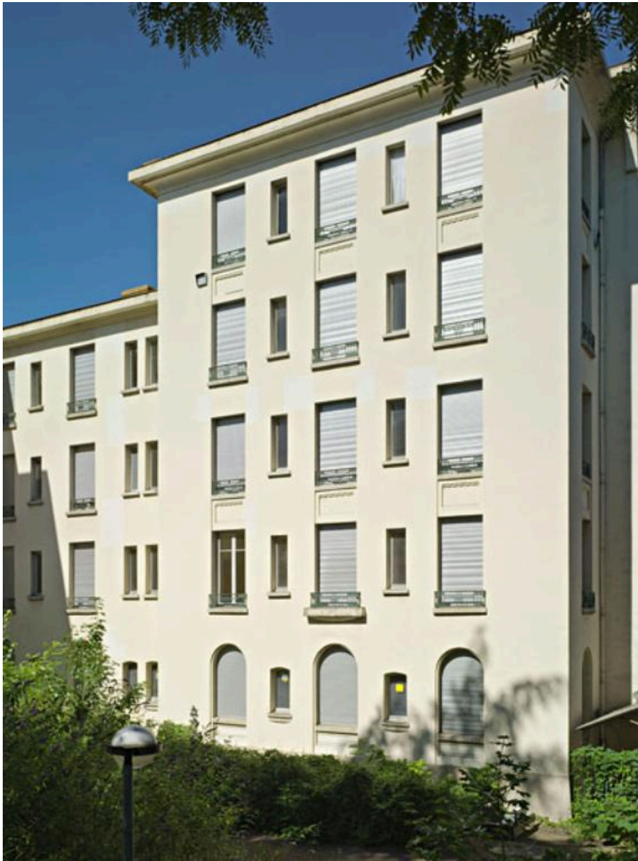
Hôtel-Dieu de Clermont-Ferrand. La polyclinique, façades orientales du corps central (partie droite) et du pavillon nord.
