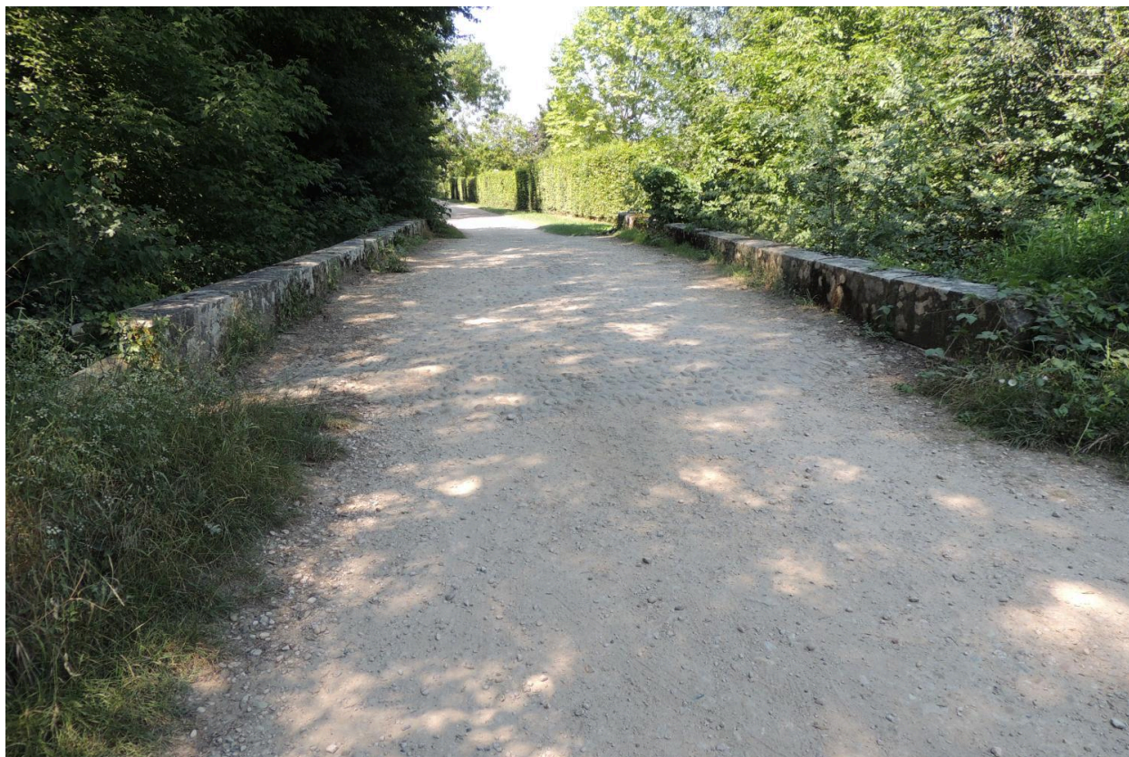
Vue d'ensemble du pont (chaussée).
