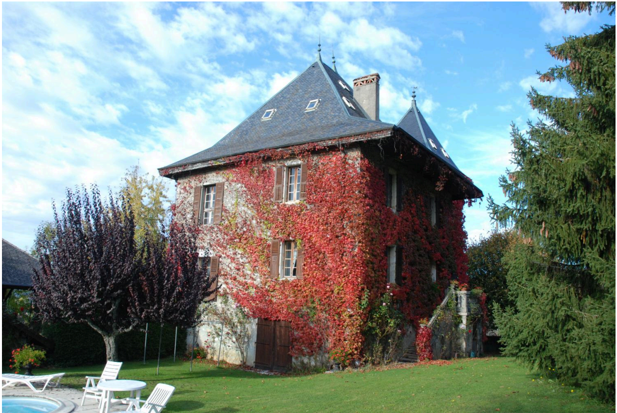
Vue depuis le sud-est.
