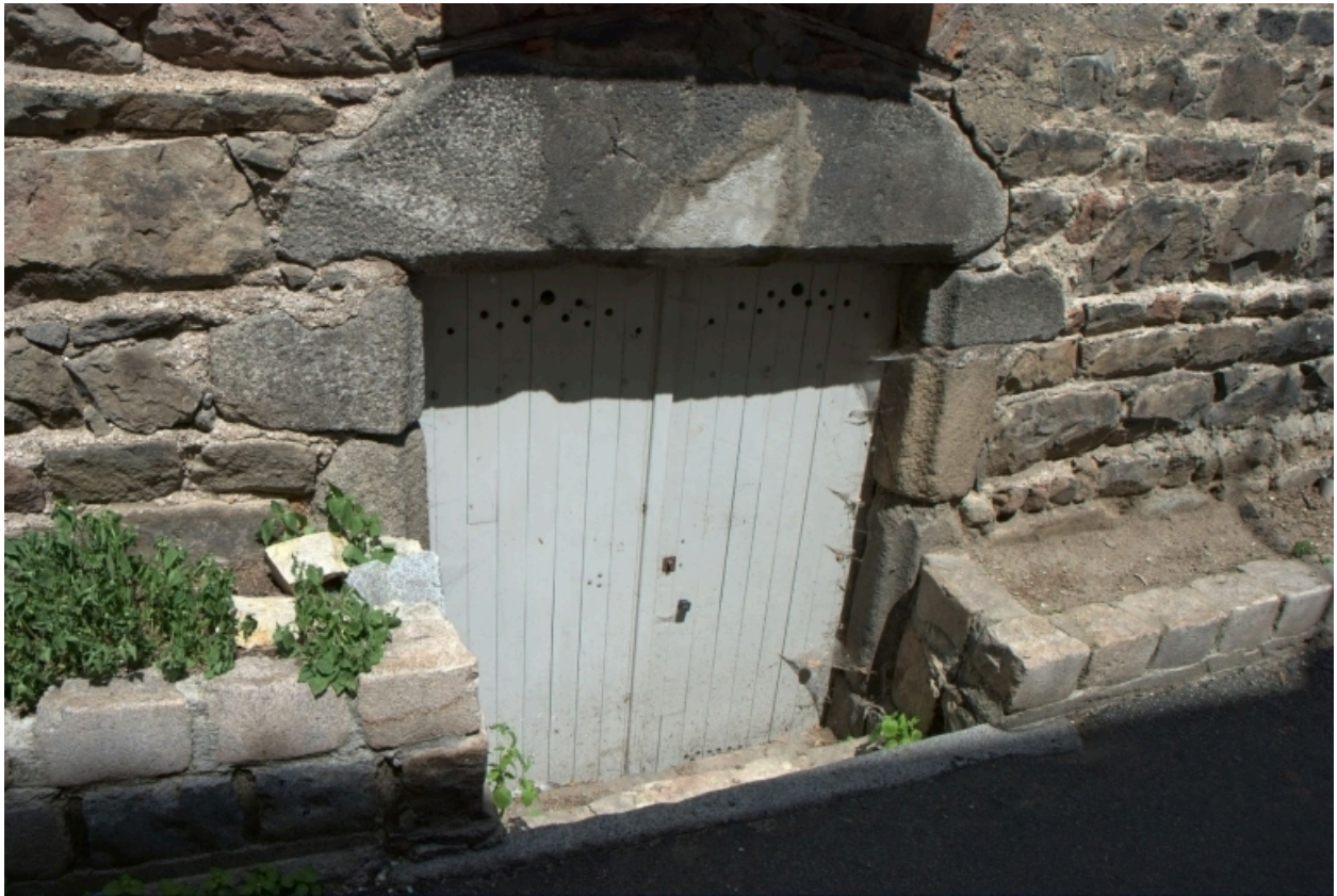
Îlot 6. Carnot (place) 15 / Veloutiers (rue des). Détail de la porte d'accès à la cave depuis la rue.
