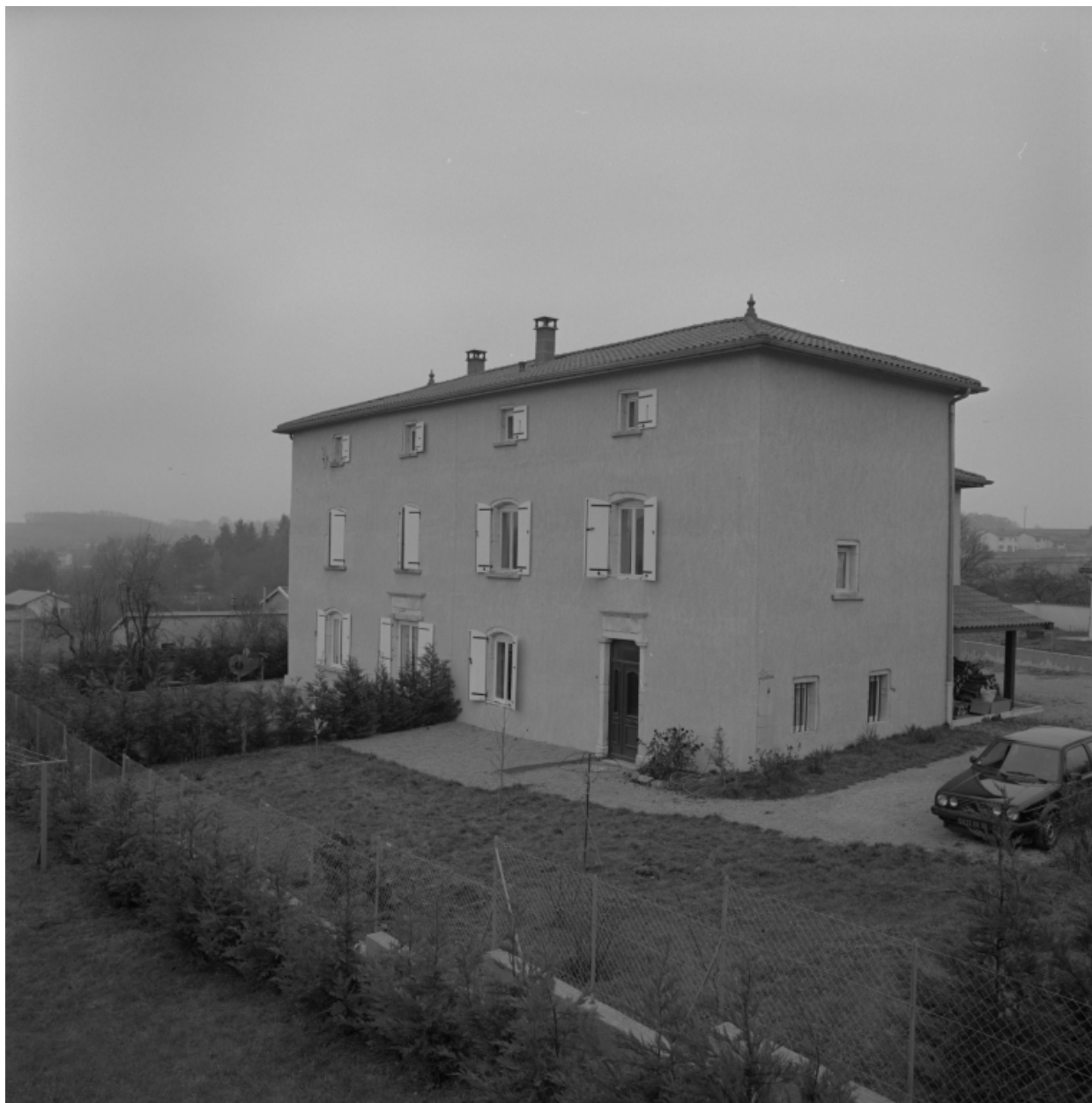
Elévation postérieure du corps de logis.
