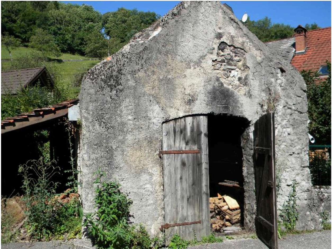
Vue de la façade du four.
