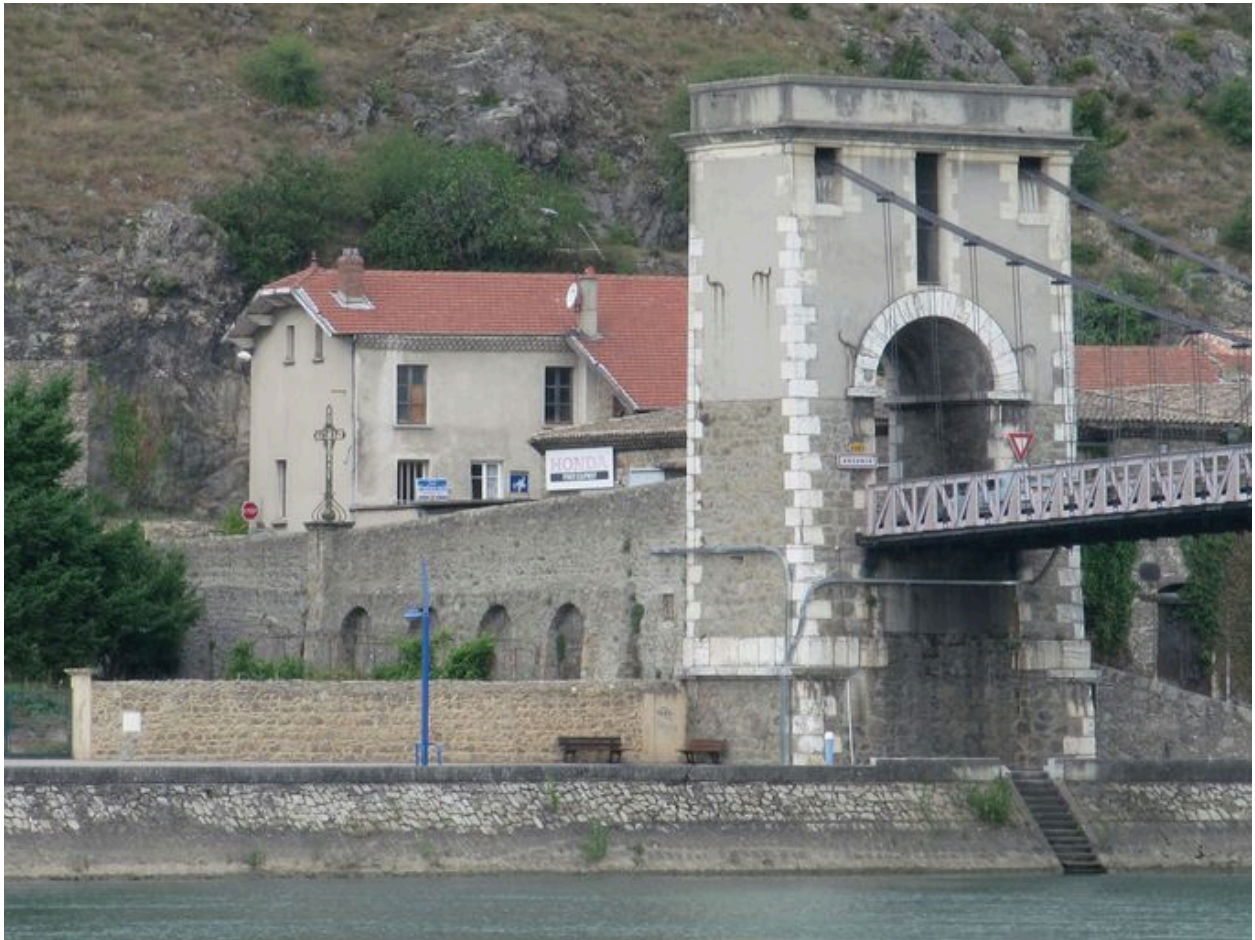
Pile droite, face aval, vue générale (depuis la rive gauche)
