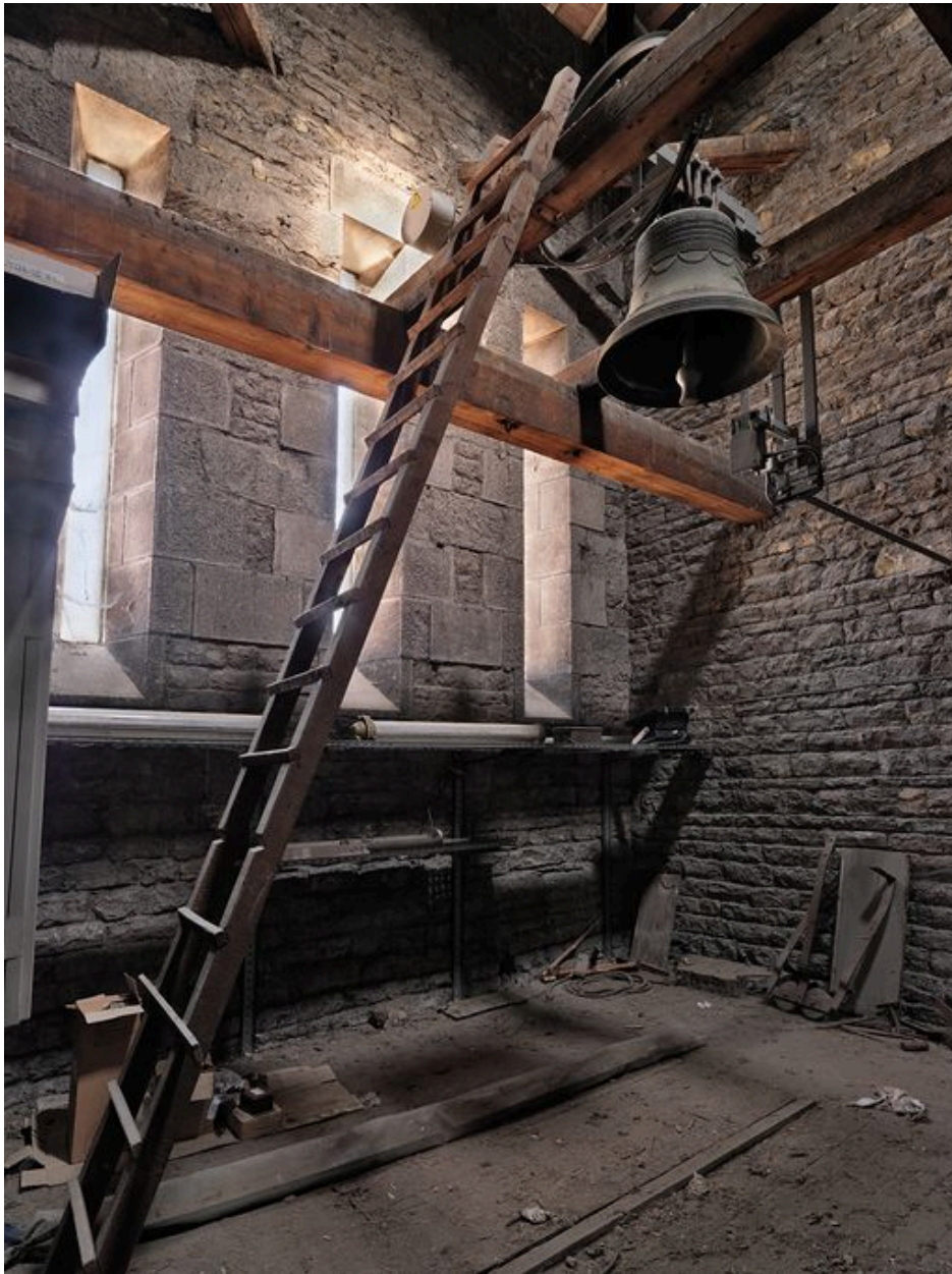
Vue des élévations intérieures du clocher.
