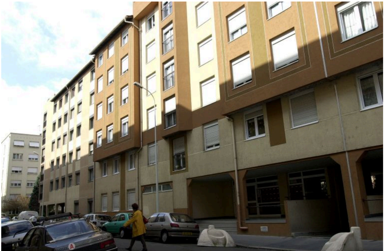
Elévation rue Delandine depuis le nord
