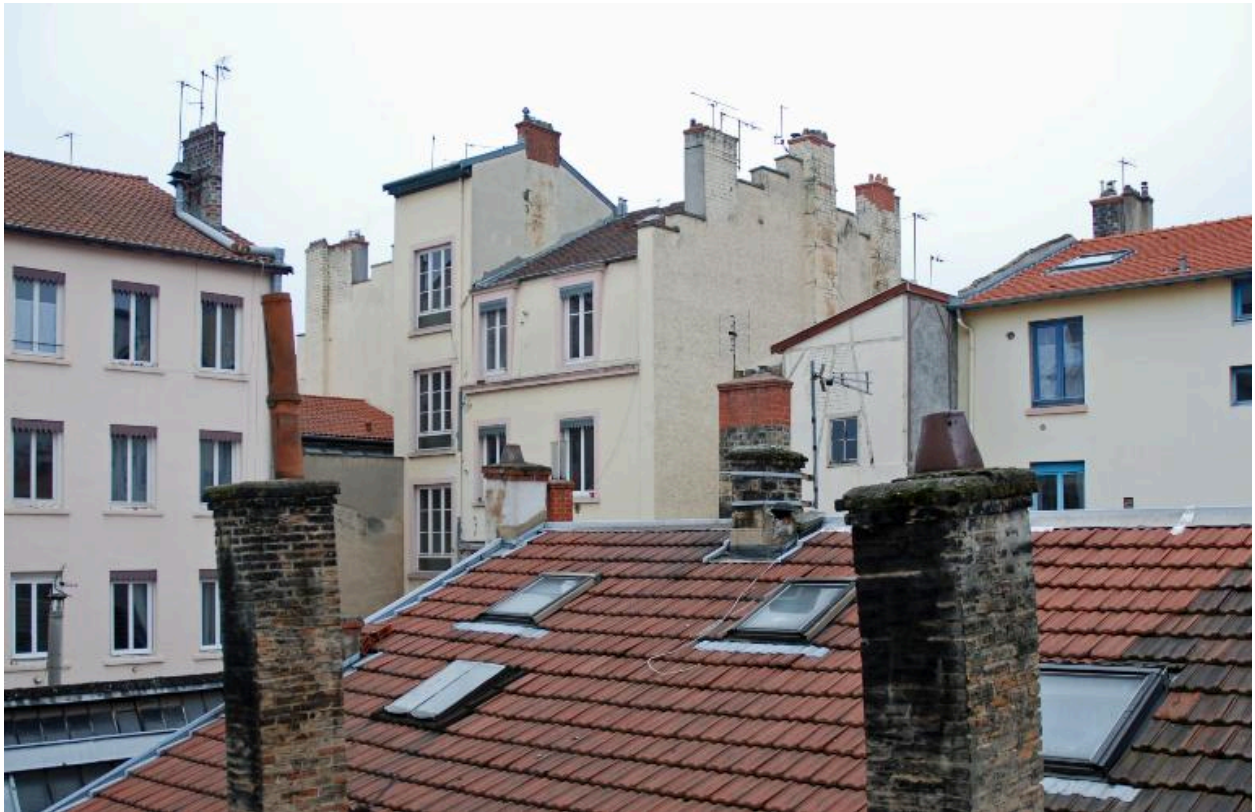
Élévation postérieure, vue lointaine
